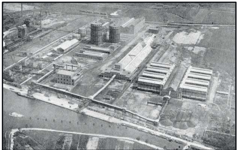
De eerste luchtfoto van de l'Azôte fabriek
