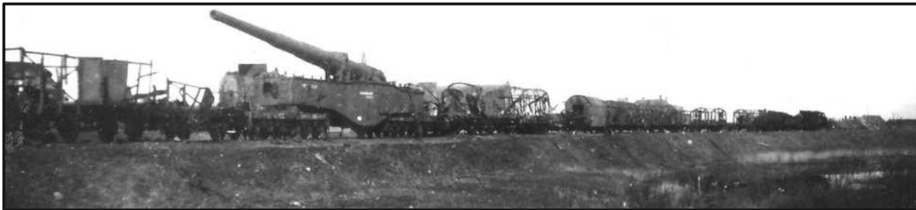
Op de spoordijk in de richting van de brug staat de inmiddels uitgebrande 'miljoenentrein'. Op de voorgrond ligt 'het Bosje'.
