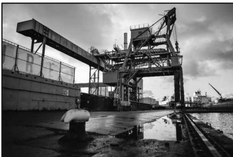
Deze installatie staat er nog steeds en was ooit onderdeel van de cokesfabriek.
